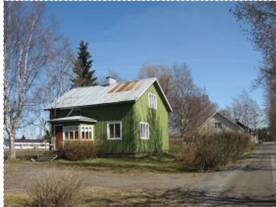
asuinrakennus lounaaseen (Kuva: TL 12.4.2007)
