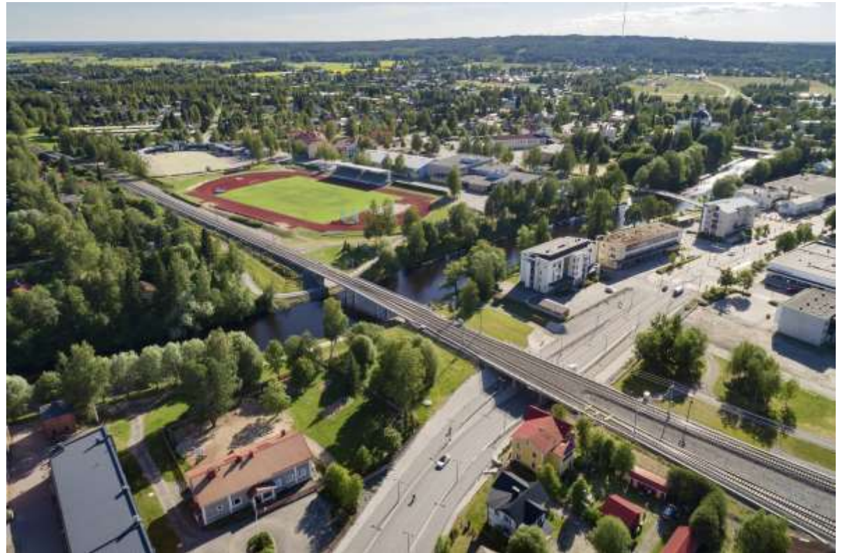
Kuva: Ramboll Finland Oy
