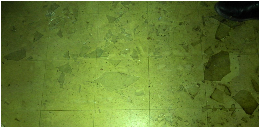
Kuva 55: Lattiamateriaalina yläkerrassa on pääosin kellertävä laatta. Ainoastaan hammashoitolan tilassa harmaa lattia, joka on kaiketi linoleumia.
