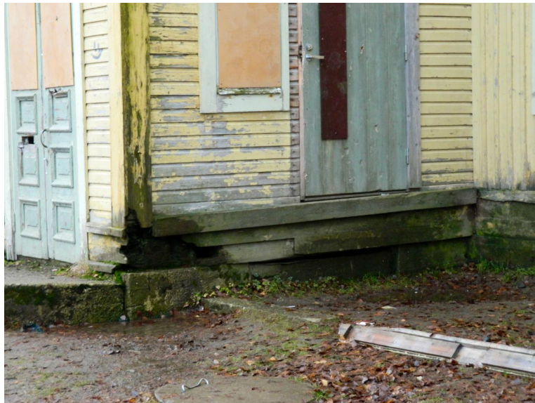
Kuvat 36-39: Huono vedenohjaus on aiheuttanut suurimmat vauriot rakennuksen julkisivuissa.
