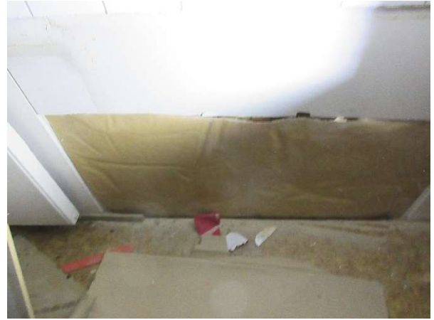
Kuva 3.33. ilmansulkupaperi levyn takana
