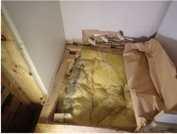
Kuva 3.66. Villaeriste, huonosti asennettuna, ilmavirtauksien muodostamaa mustumista havaittavissa myös
