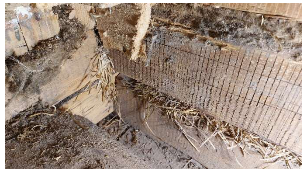
Kuva 3.93 2.krs RA9 eristeitä poistettuna välipohjasta
