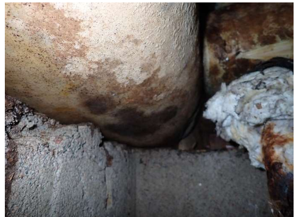
Kuva 3.2 Mikrobivaurioita materiaalien pinnalla
