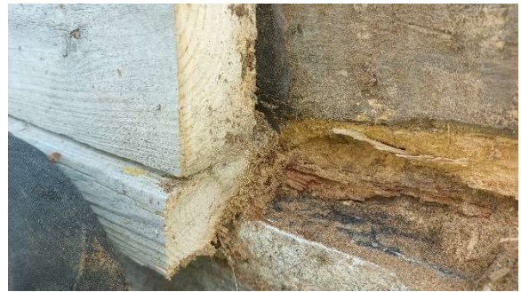
Kuva 3.8. Hirsirakenteen nurkassa lahovaurioitumista
