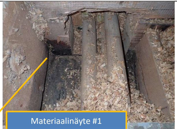
Kuva 3.60. muovimatto, lastulevy, lankkulattia
