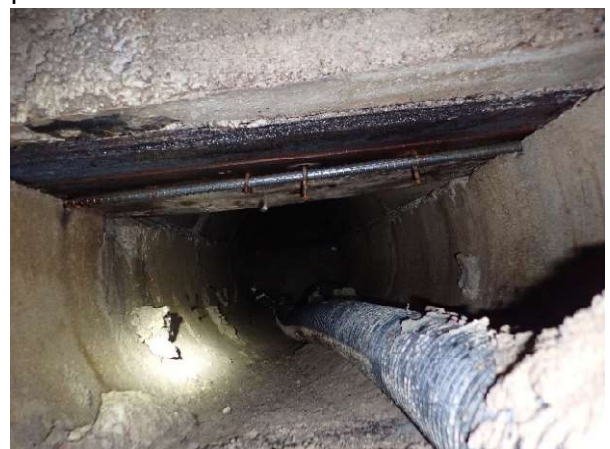
Kuva 3.2 Mikrobivaurioita materiaalien pinnalla
