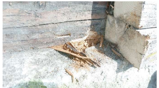
Kuva 3.15. Roiskevesien aiheuttamaa jälkeä
