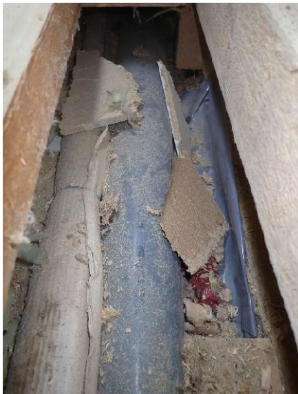
Kuva 3.77. Muovikalvo alapohjarakenteen pohjalla
