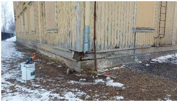
Kuva 3.7. Pinnassa olevissa lankuissa kosteuden muodostamia jälkiä
