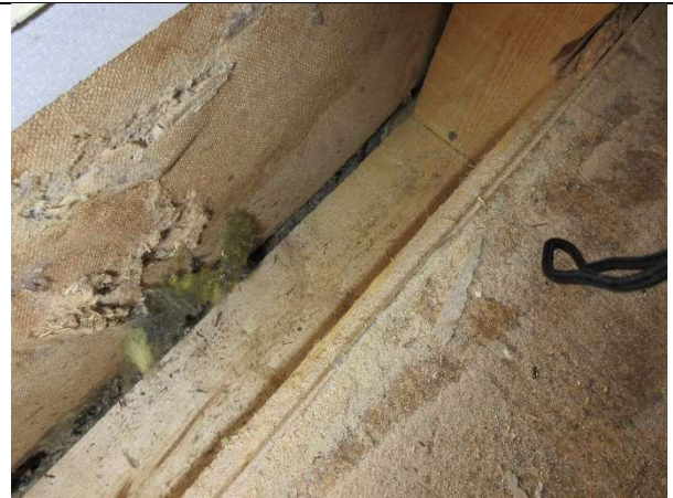
Kuva 3.33. ilmansulkupaperi levyn takana
