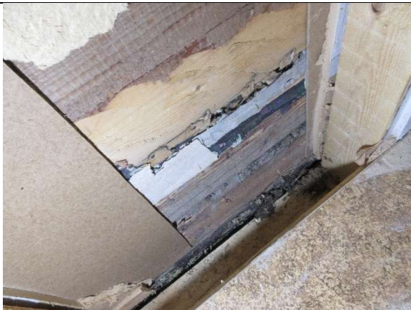
Kuva 3.34. Villaeristeessä ilmanvuotoon viittaavia jälkiä
