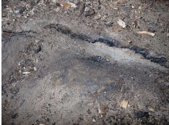
Kuva 5.1 RA #2, pohjalaatan päällä mahdollisesti kivihiilipikeä
