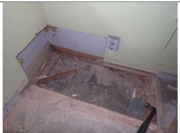
Kuva 3.60. muovimatto, lastulevy, lankkulattia
