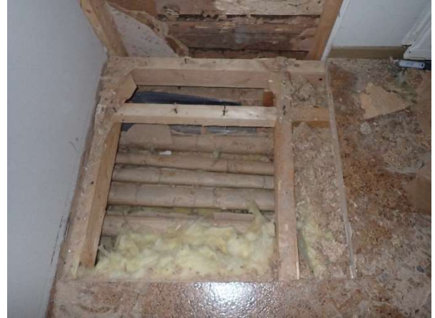
Kuva 3.76. pinta avattuna, lämmitysputkia seinälinjalla
