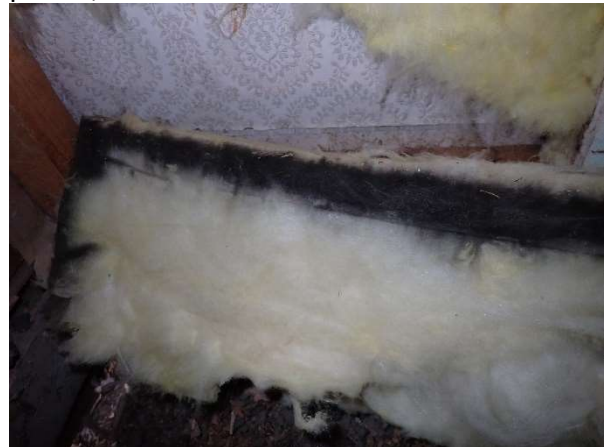
Kuva 3.26. Ilmansulkupaperi limittyy lattian pintaa, ei ole tiivis asennus
