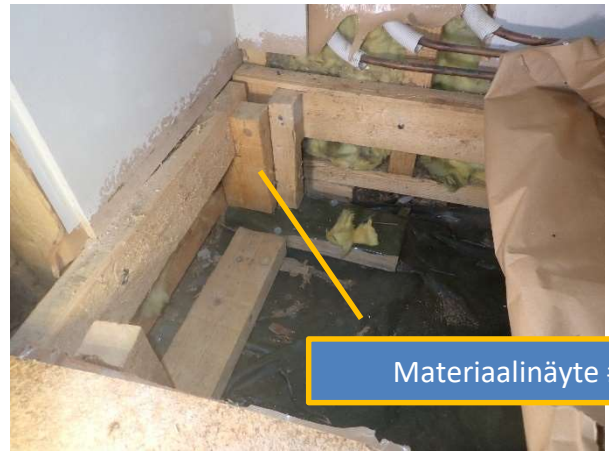
Kuva 3.67. eristeet poistettuna, tolppien taustalta otettiin materiaalinäyte viljelyyn
