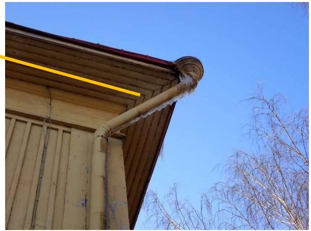
Kuva 3.19. Rännissä jääpuikkoa,
