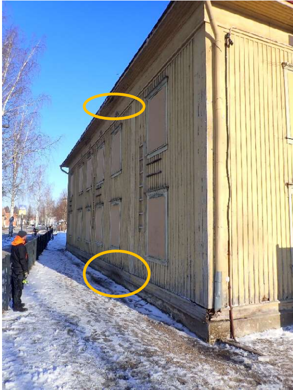
Kuva 3.14. Räystäslaudat lahovaurioituneet
