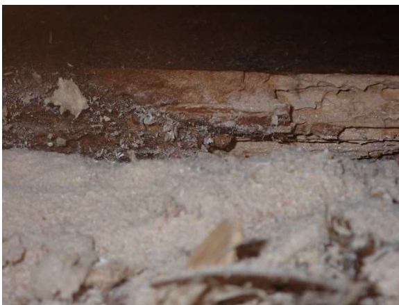
Kuva 3.40. Villaeristeessä ilmanvuotoon viittaavia jälkiä
