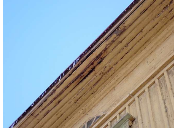
Kuva 3.14. Räystäslaudat lahovaurioituneet
