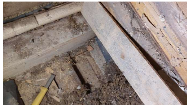
Kuva 3.85 2.krs RA7 Rakenteet näkyvissä
