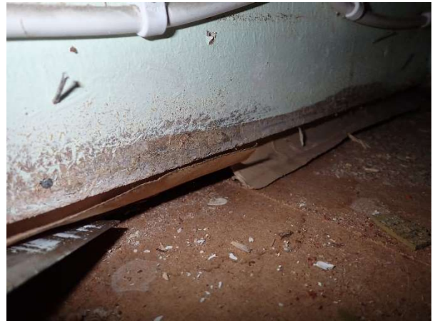
Kuva 3.26. Ilmansulkupaperi limittyy lattian pintaa, ei ole tiivis asennus
