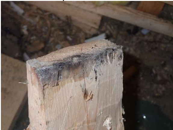
Kuva 3.66. Villaeriste, huonosti asennettuna, ilmavirtauksien muodostamaa mustumista havaittavissa myös
