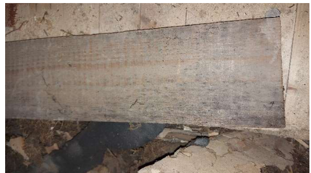
Kuva 3.81 2.krs RA6 rakenteet näkyvissä
