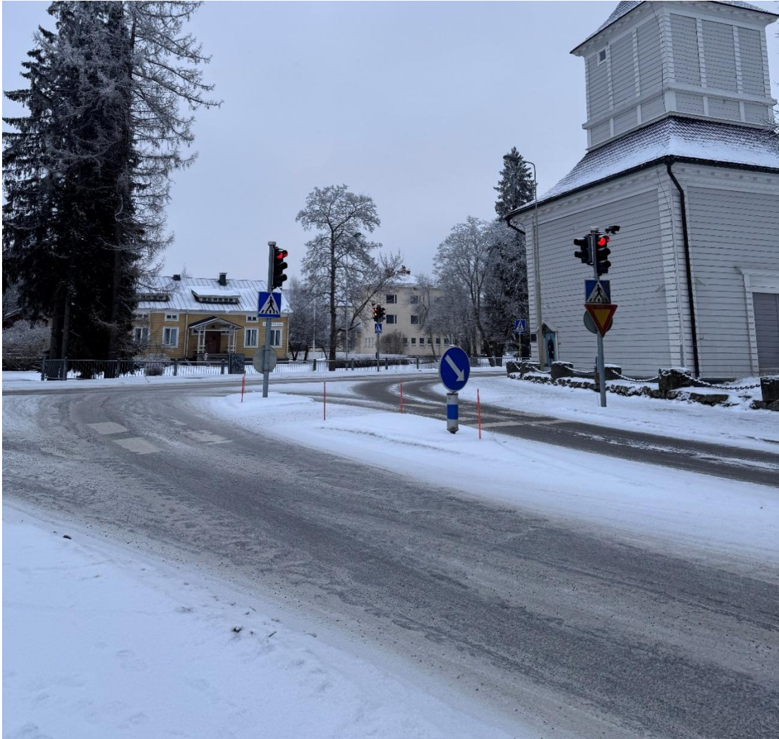
Kuva 8 Kirkkokadun ja Kosolankadun risteysaluetta
